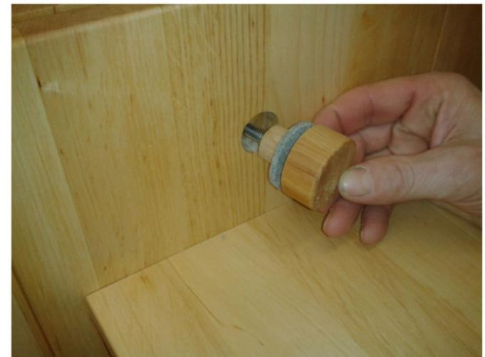
Lösen Sie vorsichtig das Außenbrett vom Seitenteil und stecken die Holz-Dübel in die nächsten Löcher, entsprechend der gewünschten Höhe
